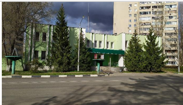
Фотография 3.1. Фасад административного здания
