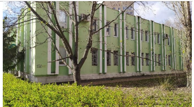
Фотография 3.2. Фасад административного здания
