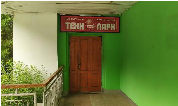
Фото 18. Входная группа по состоянию на 15.02.2019 г.
