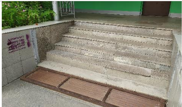
Фото 17. Входная группа по состоянию на 15.02.2019 г.
